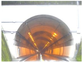
トンネル塗装
