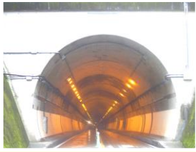
トンネル塗装
